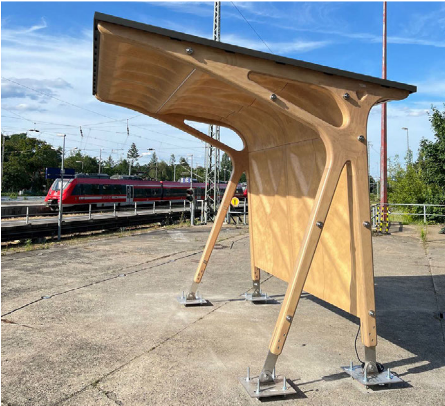
Abb. 6: Testaufbau Wetterschutzhaus aus Holzbauweise
