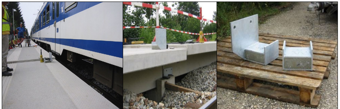
Abbildung 6: Aufhöhung mittels Distanzelementen (Quelle Fa. Hering Bau GmbH)
