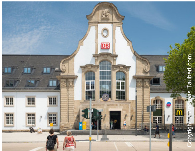
Bahnhof Marburg, DE
