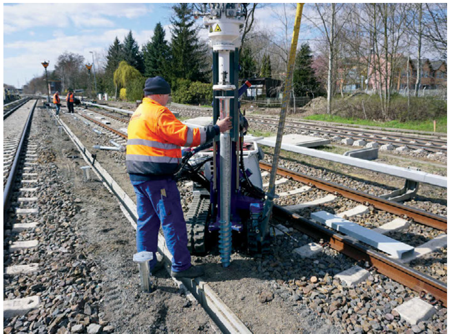
Abb. 4: Einbringen eines Schraubfundaments
