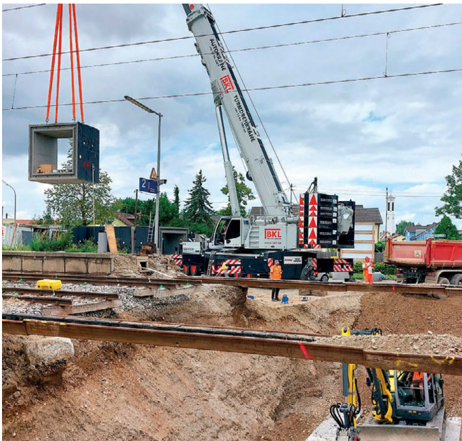
Abb. 3: Einheben eines Rahmenbauwerks aus Fertigteilen
