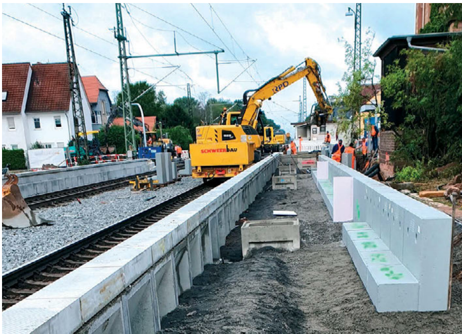
Abb. 2: Bahnsteigbau mit BSK-Elementen
