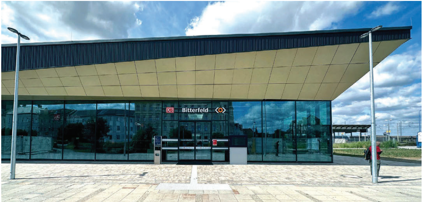
Abb. 1: Haupteingang von der Bahnhofstraße
