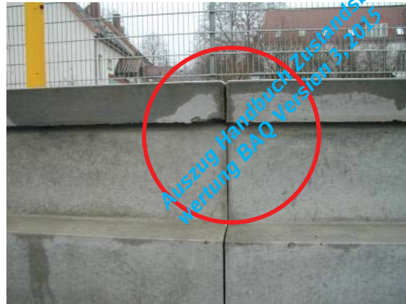
Abbildung 22 - offene Dehnfuge
