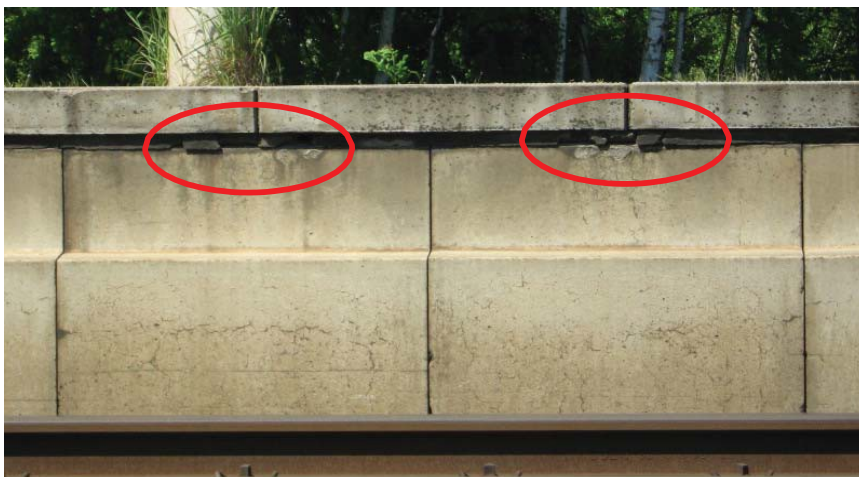
Abbildung 28 - Lagerfuge / Fehlstellen
