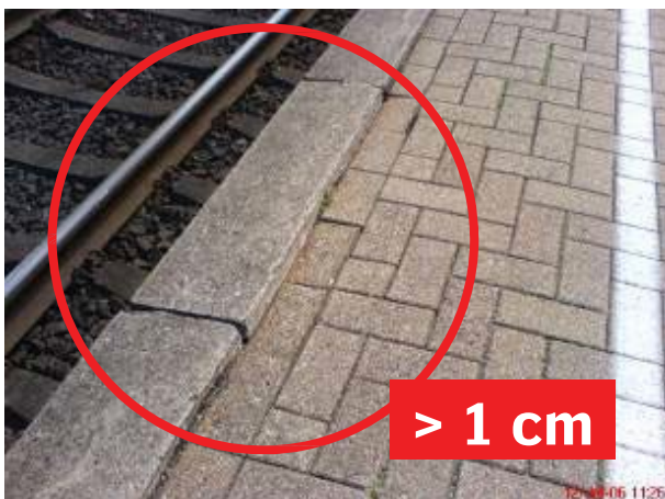
Abbildung 11 - Stolperkanten
