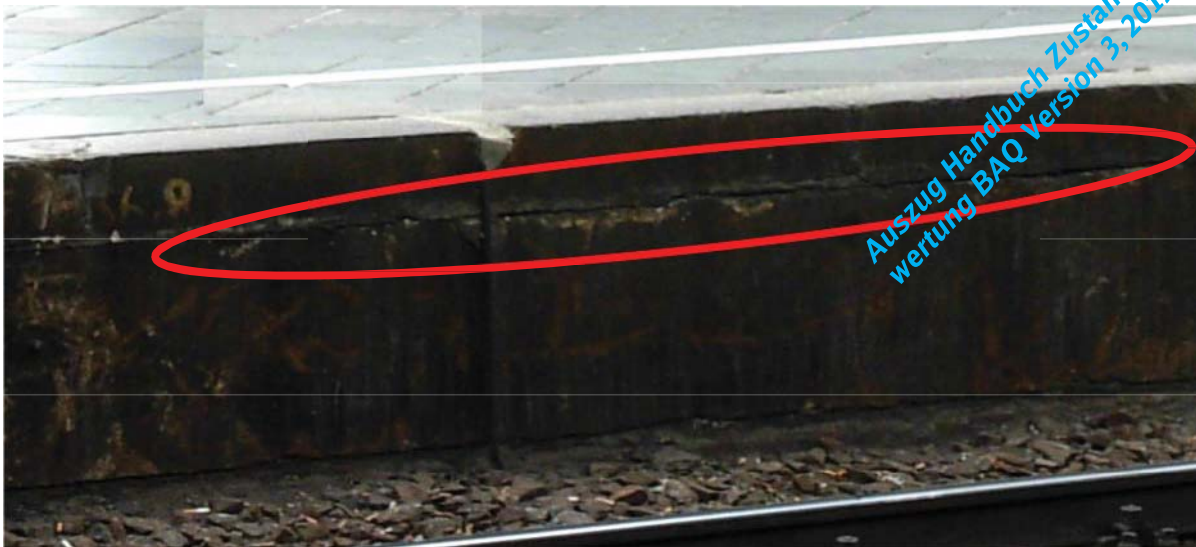
Abbildung 14 - reparabile Abplatzungen
