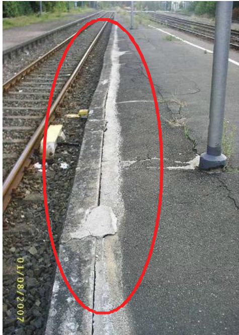
Abbildung 18 - Risse und Absenkungen
