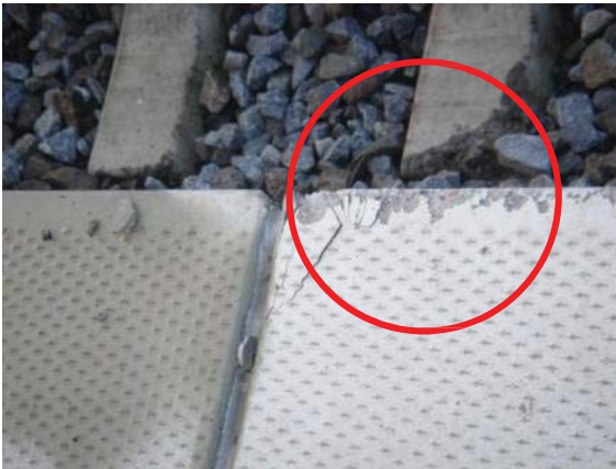
Abbildung 21 - reparabile Abplatzungen
