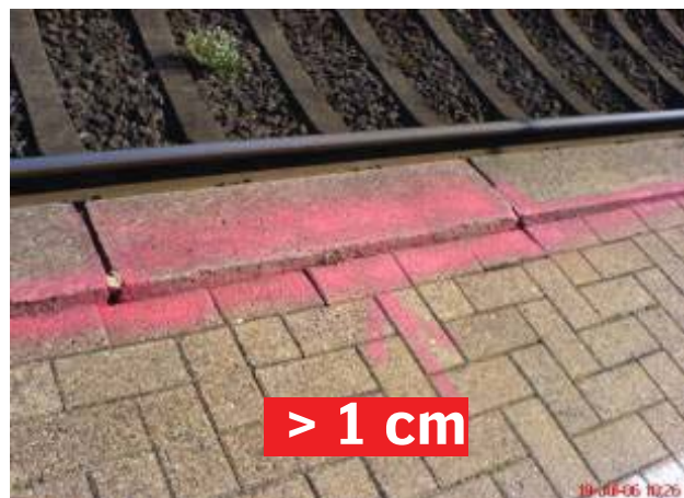
Abbildung 12 - Stolperkanten
