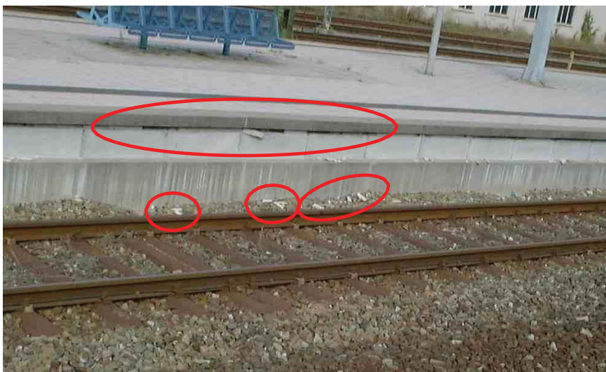
Abbildung 27 - Lagerfuge / Fehlstellen
