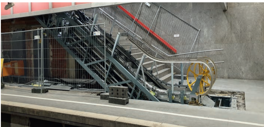
Abb. 7, 8, 9 und 10: Neubau Säulenverkleidung Rosenheimer Platz (Abb. 7, oben links), Bodenbelagsarbeiten Marienplatz (Abb. 8, oben Mitte), Neubau Wandverkleidung Marienplatz (Abb. 9, rechts), Austausch einer Fahrtreppe Hauptbahnhof Tief (Abb. 10, unten links)
