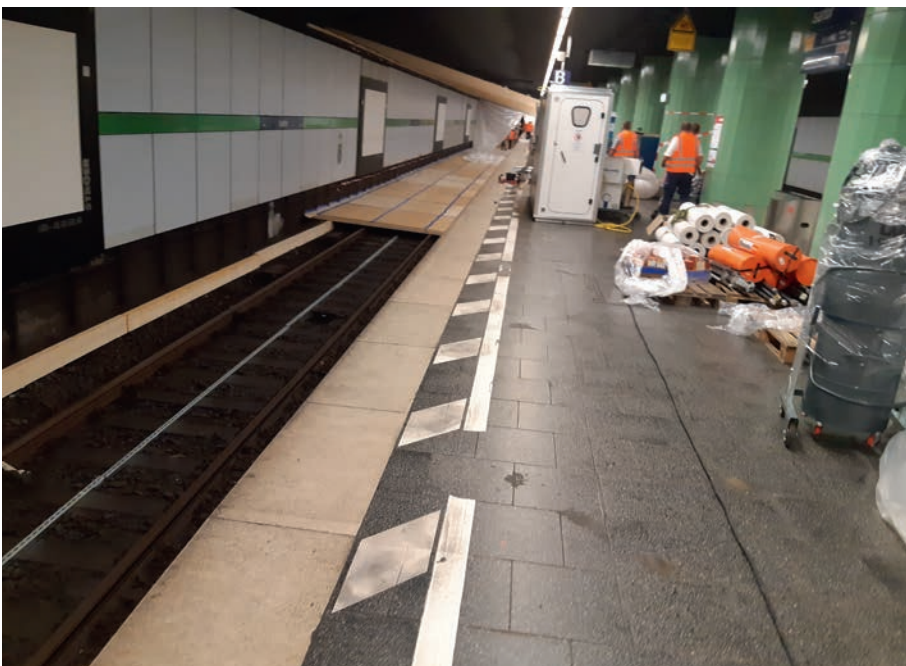
Abb. 5, 6: Gleichzeitiger Aufbau Schwarzbereich an den Stationen Isartor und Rosenheimer Platz
