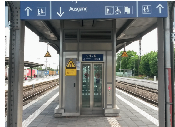
Abb. 5: Neuedingen-Friedrichsfeld, stufenfreier Zugang über Aufzug
