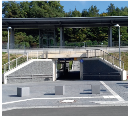
Abb. 9: Jünkerath, taktiler Weg vom öffentlichen Straßenraum zu den Bahnsteigen, ertastbar durch taktilen Leitsystem aus Bodenindikatoren
