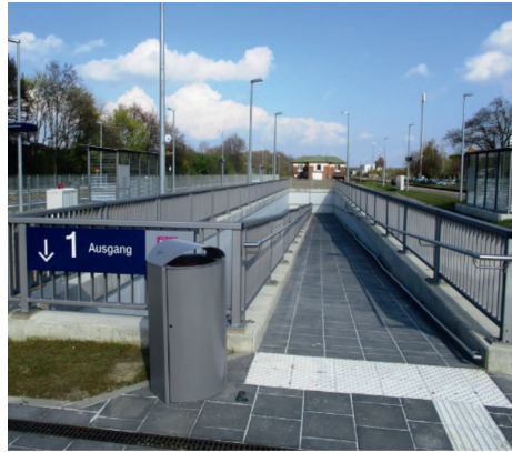
Abb. 4: Salzgitter-Ringelheim, lange Rampe zur Personenunterführung
