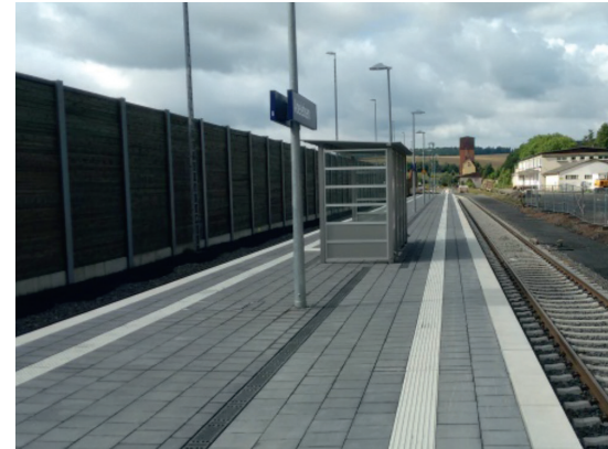
Abb. 10: Adelebsen, Taktile Leitstreifen auf dem Bahnsteig markiert den Sicherheitsabstand zum Gleis
