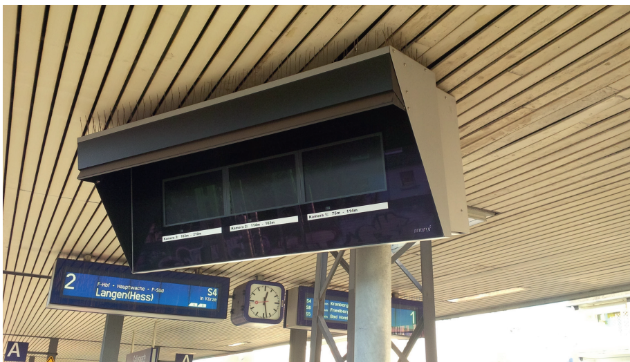
Abb. 2: Bestehende VA an der Station Galluswarte Quelle: Torsten Kuhlmeiy
