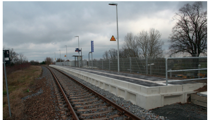
Abb. 7: Neu gebauter Bahnsteig 1 am Bahnhof Werbig
