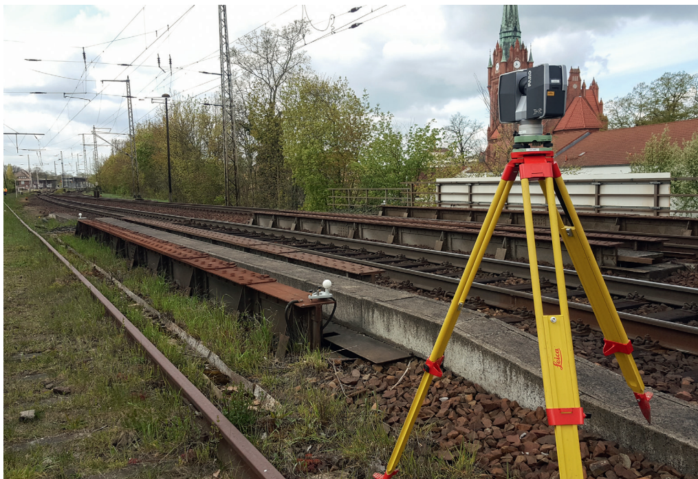
Abb. 1: ScanStation im Einsatz
