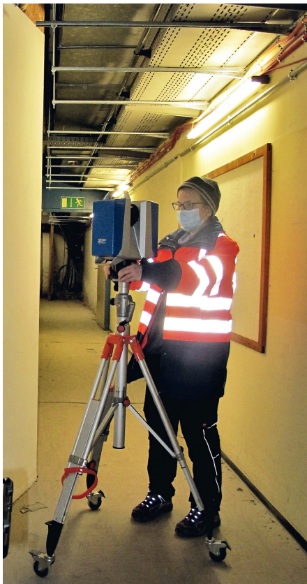
Abb. 1: Aufstellung eines Laserscanners im 1. Untergeschoss, Frankfurt am Main Hbf
