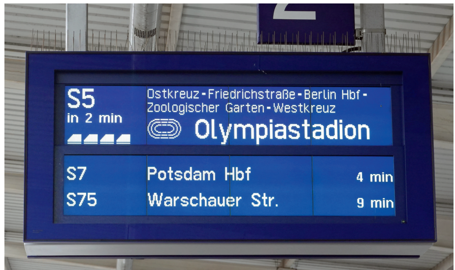
Abb. 3: TSI PRM konformer Fahrgastinformationsanzeiger (FIA) an einer Station der DB S&S
