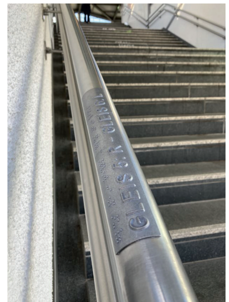
Abb. 8: Taktile Handlaufschalter dienen der Orientierung für blinde Reisende.
