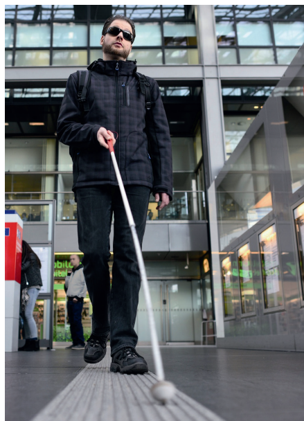
Abb. 7: Blindenleitstreifen erleichtern blinden und sehingeschränkten Reisenden die Orientierung.
