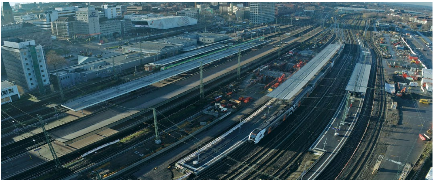
Abb. 2: Baustellensituation im Bahnhof Dortmund im September 2021
